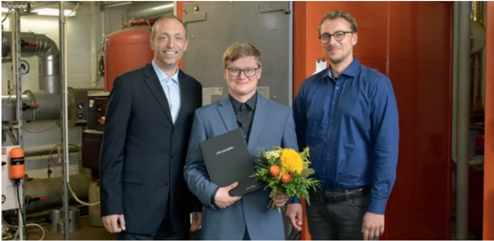
Glückliche Gesichter in der Heizzentrale im Gewerbepark Wilthener Straße: Prof. Dr.-Ing. Matthias Kunick von der HSZG, Jonas Pfeiffer und EWB-Betreuer Benjamin Walde in der Heizzentrale im Gewerbepark Wilthener Straße (v.l.n.r.).
